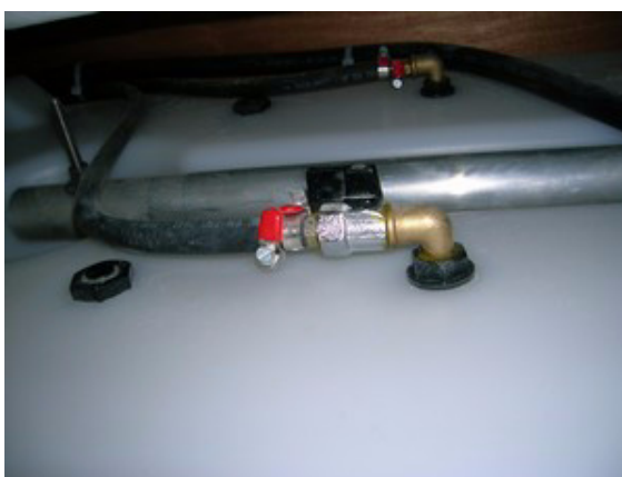
VÁLVULA DE ALIMENTACIÓN SOBRE EL DEPÓSITO
