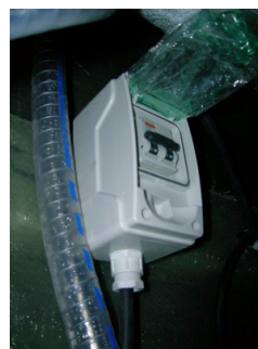
Disyuntor 220V - 32A Acceso - Cofre Bañera de estribor
