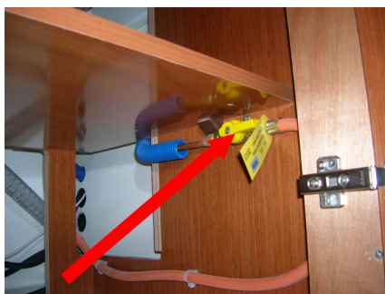
La válvula está ubicada bajo el mueble de la cocina (Referencia 2)
