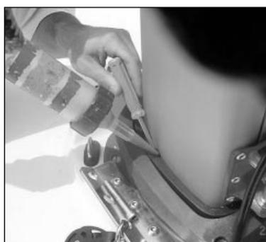
Pour une étanchéité parfaite au niveau du pont, rajouter un joint de silicone entre le tour du mât et la cale d'étambrai.
