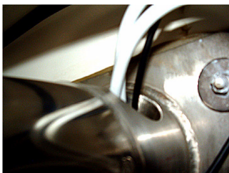
Sortie du faisceau de mât en haut de l'épontille
